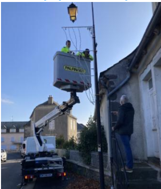
Installation des illuminations de Noël
